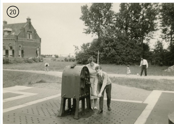
Handmatig openen van de sluisdeuren
