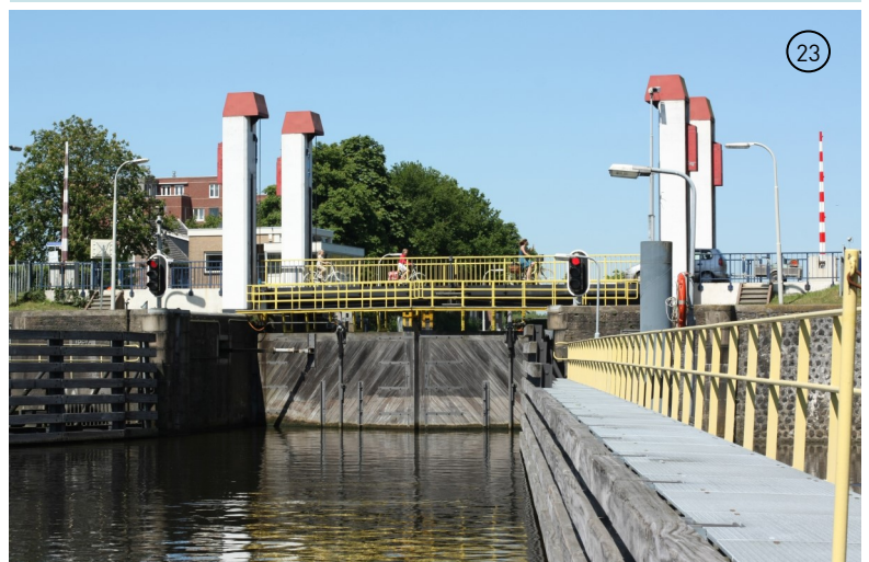
↓ Huidige sluis Engelen
