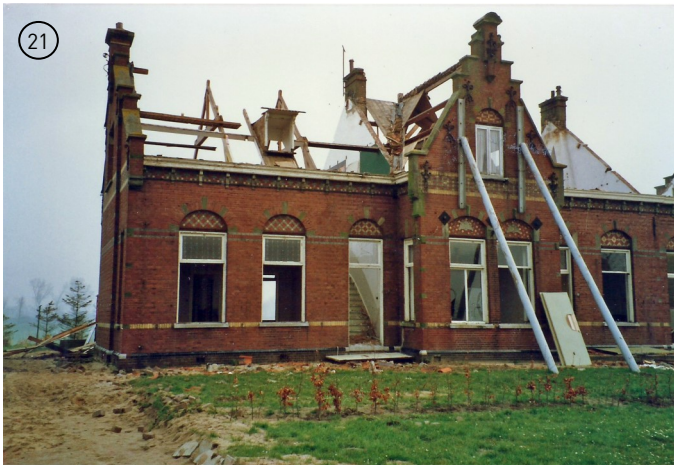
Sloop van de woningen in 1988
